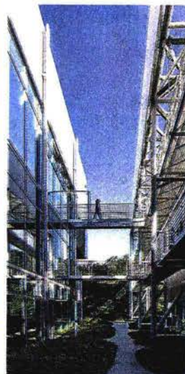
Inserita nel paesaggio Una fabbrica-giardino con 29mila arbusti e 300 alberi pensata per il benessere di chi ci lavora e la guarda. E' Valvigna, la nuova sede di Prada nell'aretino. Completata l'anno scorso, ospita tra le altre cose lo sviluppo della pelletteria Prada e Miu Miu . Il progetto è dell'architetto Guido Canalì.
